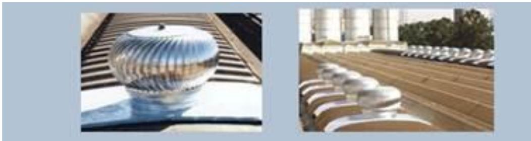
térmica, devido a diferença térmica entre o ar interno e o externo. A massa de ar quente, por ser mais leve, desloca-se na direção do exaustor, exercendo pressão nas palhetas do rotor, movimentando-o — R- A
